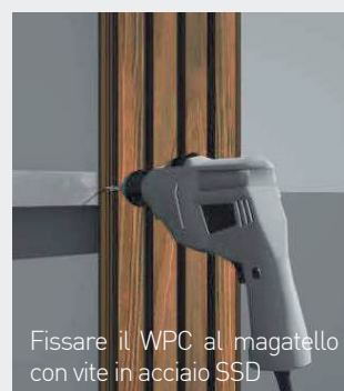
Preforare il WPC ed il magatello ad una profondità idonea
